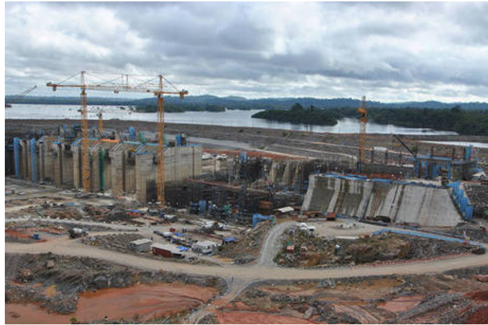
Figura 6: Concreto e sangue na casa de Maíra, Belo Monte
