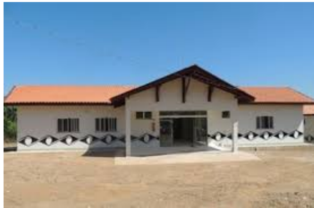
Figura 12: Unidade de Saúde Construída pela Norte Energia
