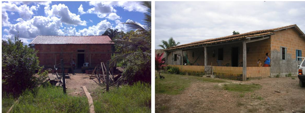
Figura 17. Casas do PA Belo Horizonte. Na imagem da direita pode-se perceber a antiga casa em madeira ao fundo da casa de alvenaria.
