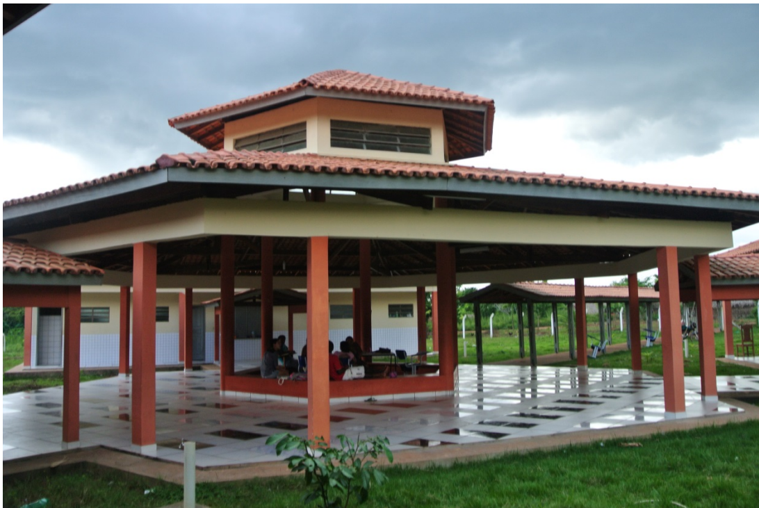
Figura 7. Área central da escola Sawarapy Suruí.
