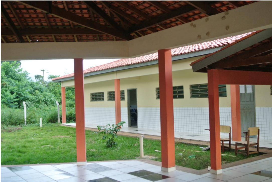
Figura 8. Bloco com quatro salas de aula da escola Sawarapy Suruí.
